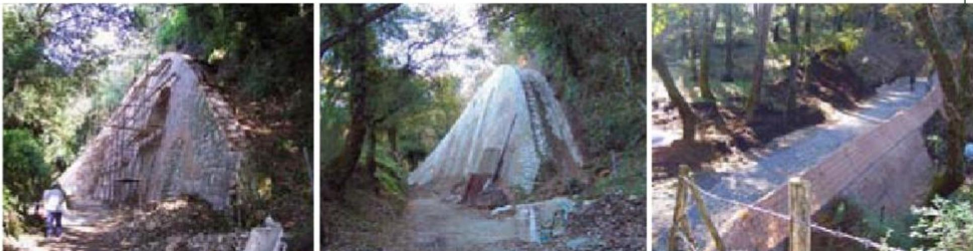
Da sinistra a destra: 34-35 due fasi del recupero (2007) del muro di contenimento ad archi in laterizio e pietrame (nella Riserva Naturale del Bosco della Ficuzza, linea Palermo-Corleone). Dopo la ricollocazione del pietrame, con funzione di vespaio, all'interno delle arcate portanti, viene recuperata la funzionalità del grande "cunettone di gronda" posto al di sopra dell'intera cimasa del muro, per drenare le acque meteoriche; 36 ricostruzione in "terramesh" di uno dei rilevati ferroviari.
